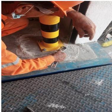
❖ FABRICACIÓN E INSTALACIÓN DE 12 POSTES ANTI IMPACTOS
