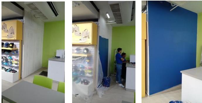
✦ **SUMINISTRO E INSTALACIÓN DE MURO DE TABLAROCA A UNA CARA PARA OCULTAR TUBERÍAS EXISTENTE CON SUMINISTRO Y APLICACIÓN DE PINTURA VINÍLICA EN MURO.**
