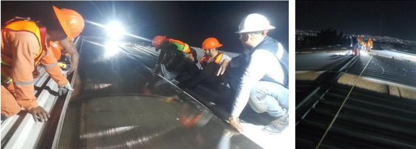
❖ **APLICACIÓN DE IMPERMEABILIZANTE Y COLOCADO DE MEMBRANA PARA EL SELLADO COMPLETO DE JUNTAS.**
