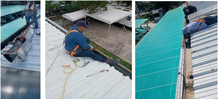
❖ **SUMINISTRO E INSTALACIÓN DE 50 METROS LINEALES DE CANALÓN PLUVIAL LADO DERECHO.**
