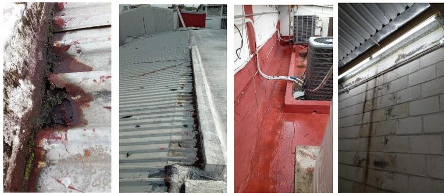
❖ **SUMINISTRO Y APLICACIÓN DE 160 M2 DE IMPERMEABILIZANTE CON MEMBRANA PARA SELLAR TECHUMBRE Y LOSA DE AREA DE BODEGA.**
