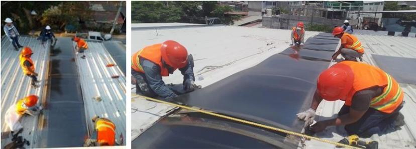
❖ **DESMANTELAMIENTO, SUMINISTRO E INSTALACIÓN DE 18 DOMOS DE PANEL POLICARBONATO EN TECHUMBRE.**
