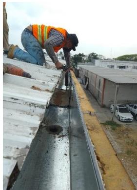
❖ SUMINISTRO E INSTALACIÓN DE 50 METROS LINEALES DE CANALÓN PLUVIAL LADO IZQUIERDO.
